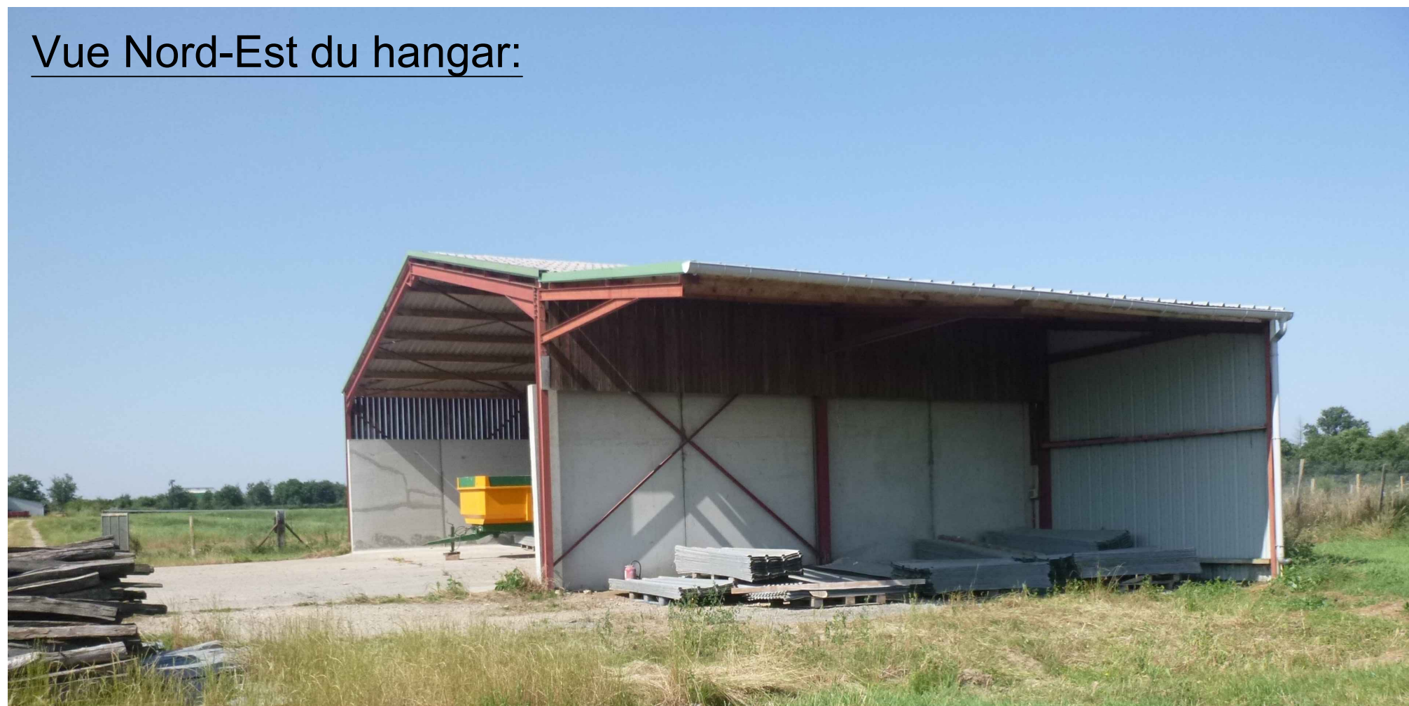
Vue Nord-Est du hangar:
